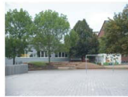
Fertiggestelltes Abtritts und die neu angelegte Begegnungsfläche mit Tor
