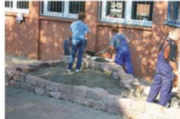
Herstellung der Trockenmauer zur Erhebung des Pflanzbeetes
