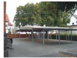
Überdachter Versammlungs- und Begegnungsraum für die Schüler und Lollarer Bürgerinnen und Bürger
