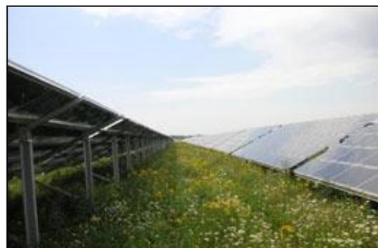
**Abb. 13:** Beispiel für aufgeständertes Modulfeld
